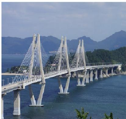
【巨加跨海大橋+海底隧道】總長達8.2km，由海上斜張橋(3.5km)、海底隧道(3.7km)和路上隧道(1.0km)組成。隧道起點還興建了一座巨加島展望台提供旅客休憩，欣賞秀麗的風光。巨加連接釜山江西區的加德島和廣尚南道巨濟市長木面，海上斜張橋與南海美麗風光融為一體，大橋更是有效促進了景觀秀麗的南海岸城市發展。
